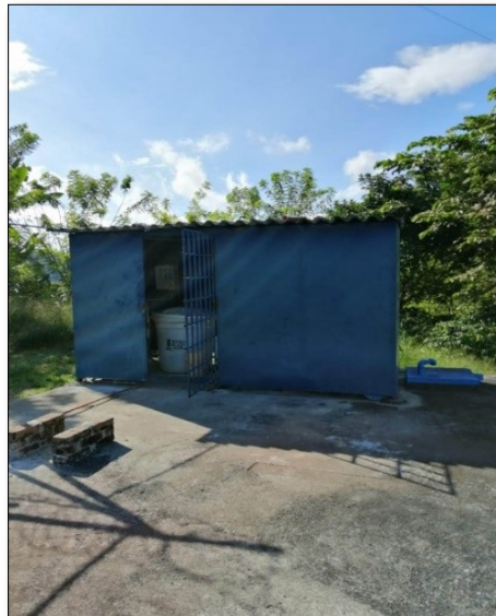
Imagen 11. Caseta de Cloración y Dosificación Planta Oriente Administración Cooperativa Ulloa E.S.P.
