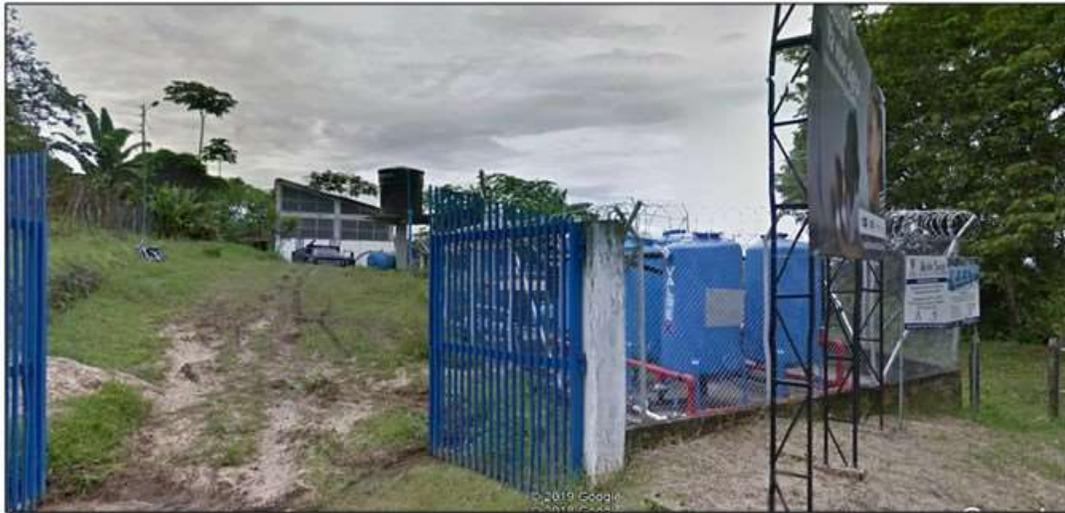
La planta de tratamiento Berlín tipo Valrex manejada por gravedad tiene una entrada en 6" y se deriva para 6 filtros en 3" (3 ascendentes y 3 descendentes) y sale al tanque de almacenamiento en 6".
